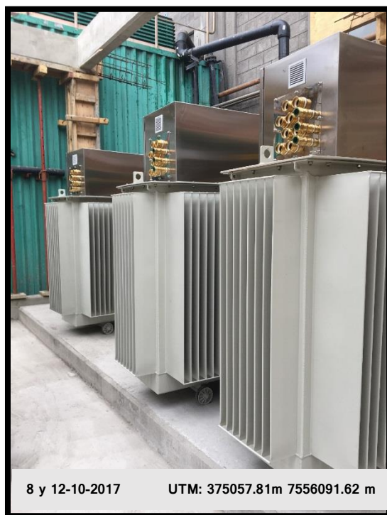
Figura 6: Montaje de transformadores rectificadores A, B y C.
