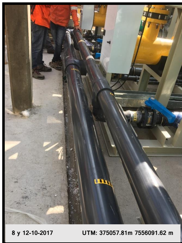
Figura 10: Líneas de 4 y 6 pulgadas, entrada de agua de mar y salida de Hipoclorito de Sodio respectivamente
