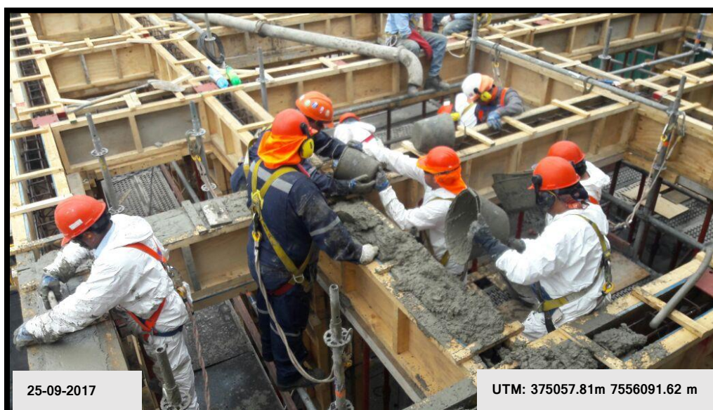
Figura 2: Hormigonado losa 3er piso edificio planta electrocloración
