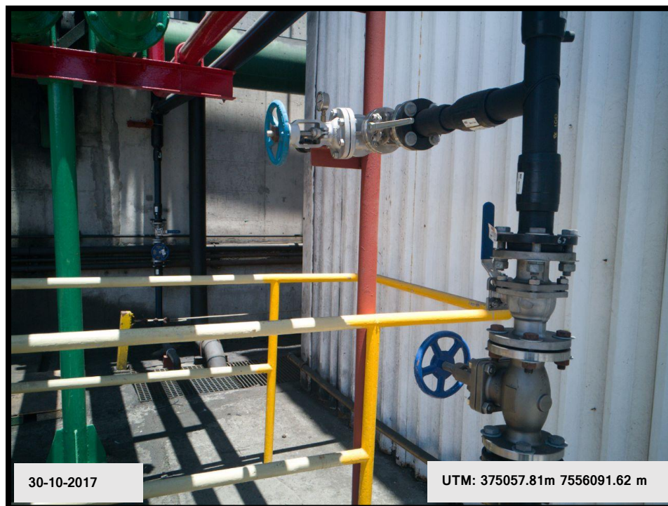
Figura 24: Montaje rack válvulas de entrada de hipoclorito de sodio a intake, unidad 2.
