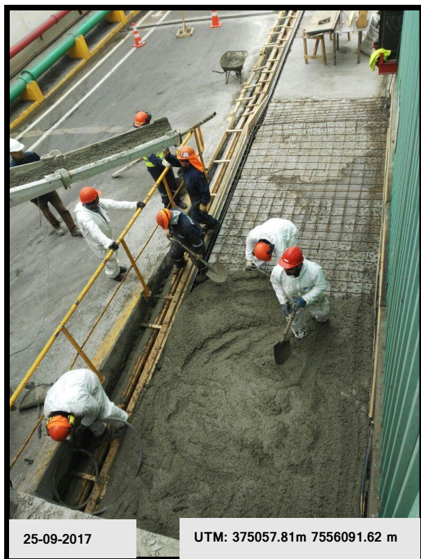
Figura 3: Hormigonado canaleta drenaje de riles planta de electrocloración
