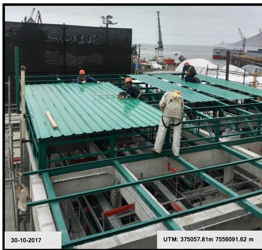
Figura 27: Instalación de recubrimiento de edificio planta electrocloración
