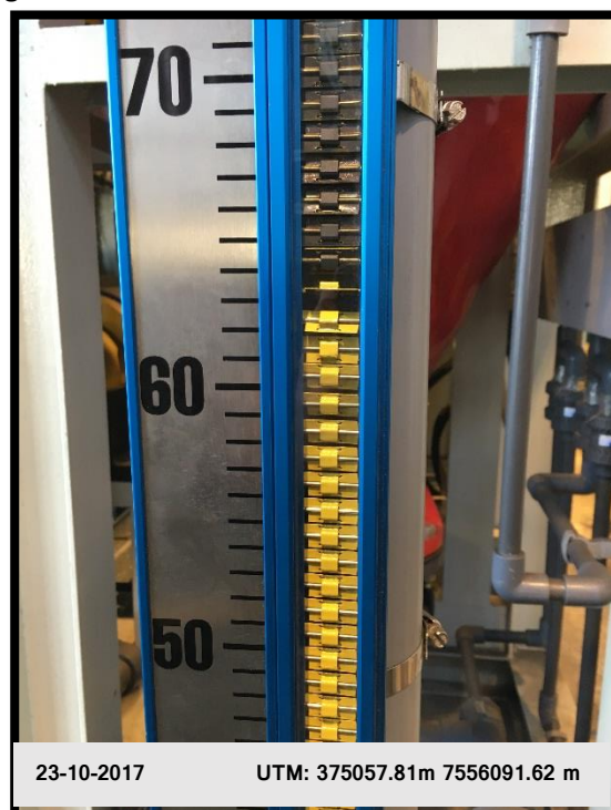
Figura 19: Octubre 2017 Medidor de nivel de llenado del Hidrociclón (separador Hidrógeno/ agua).
