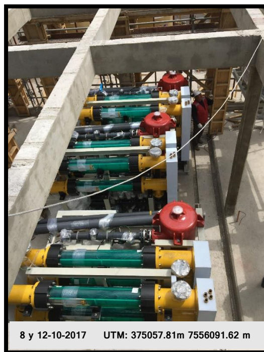
Figura 9: Posicionamiento de los tres módulos de electrólisis.
