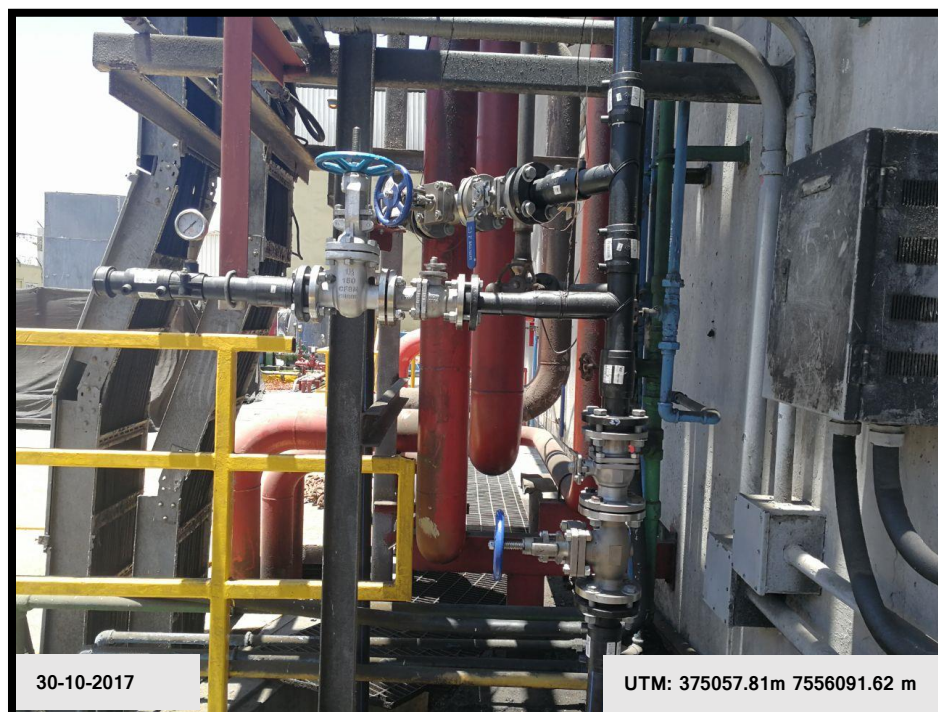
Figura 25: vista rack válvulas de entrada de hipoclorito de sodio a intake, unidad 1.
