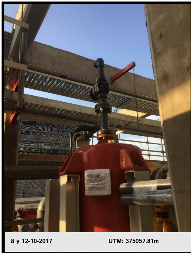
Figura 12: Equipo Hidrociclón (separador Hidrógeno/agua).
