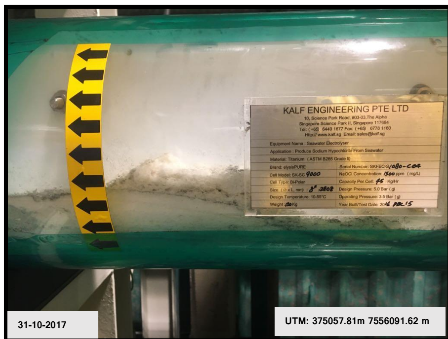
Figura 28: Celda de electrólisis módulo C, se aprecia precipitado de carbonatos y sulfatos generados durante el proceso.
