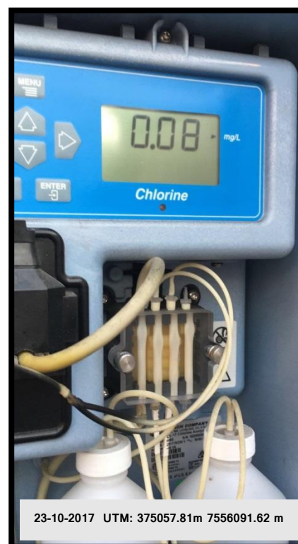
Figura 21: Octubre 2017 Gabinete analizador de Cloro total en la descarga de las bombas circuladoras de la unidad
