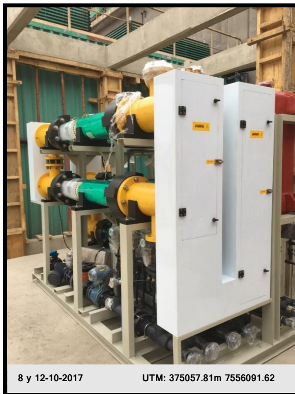
Figura 7: Posicionamiento de celdas de electrólisis, módulo C.
