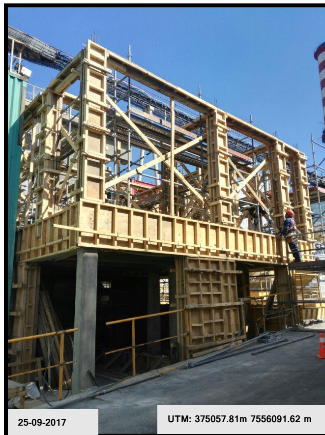
Figura 1: Hormigonado de pared norponiente edificio planta electrocloración.
